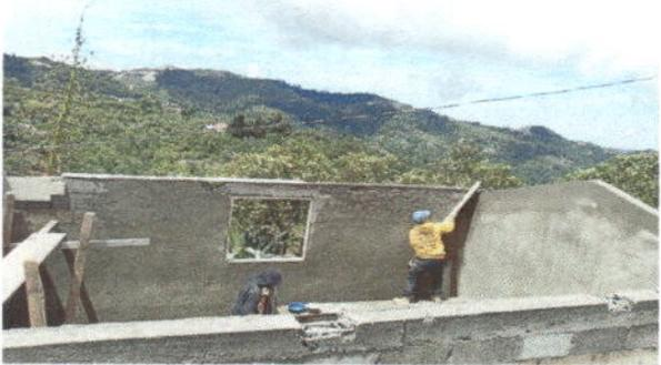
FOTO 3 Bodega sustitucion de lamina, techo y repello de pared
